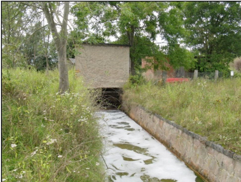
Abb. 3: Mundloch des Schlüßelstollens
