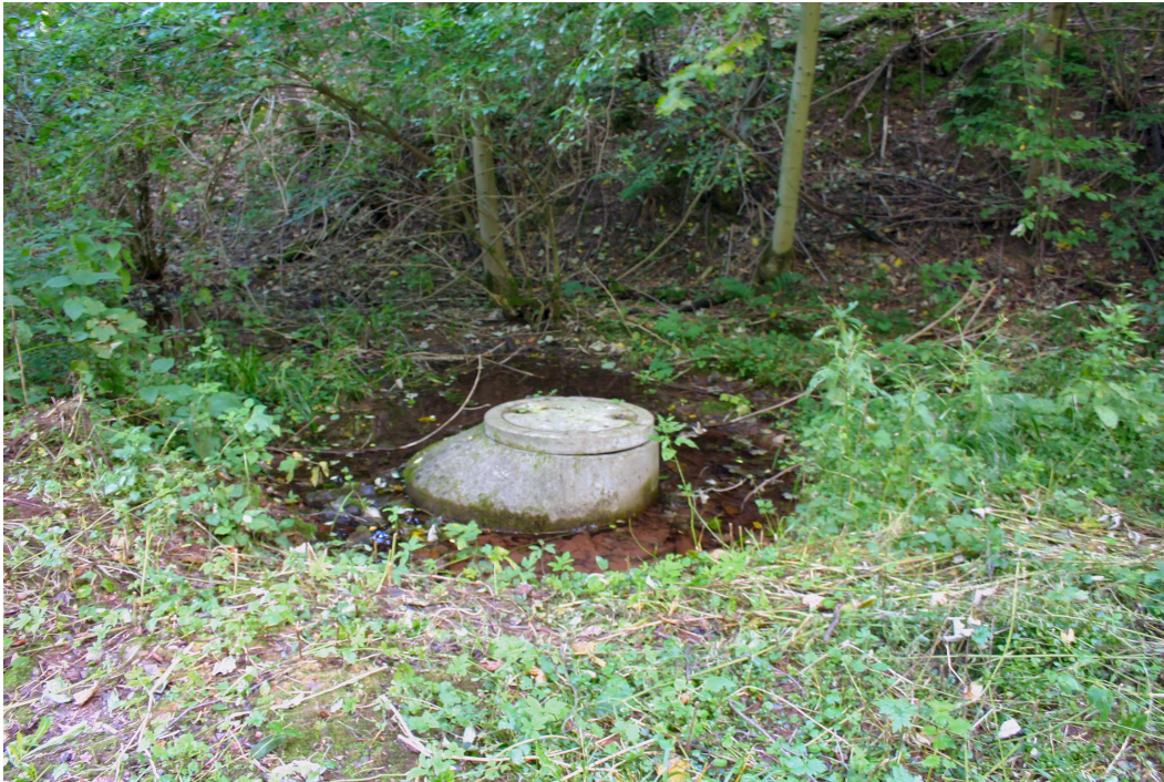
Abb. 3.2.-11: Fassung des ablaufenden Wassers aus dem Neuen Eskaborner Stollen
