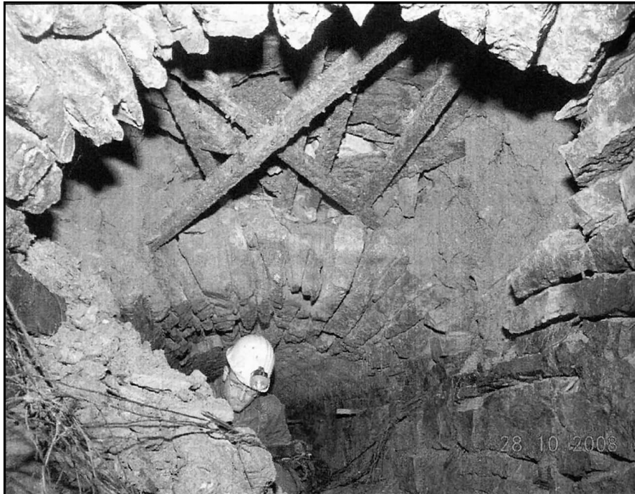
Abb.2 : Teilverbrochener Stollen unter der Parkanlage des Novalis-Schlusses
