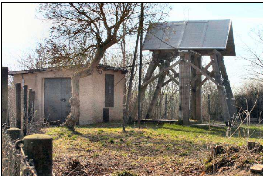
Abb. 3.3.2.2.-5 Das Schachtfördergerüst des LL 20 des Zabenstedter Stollens
