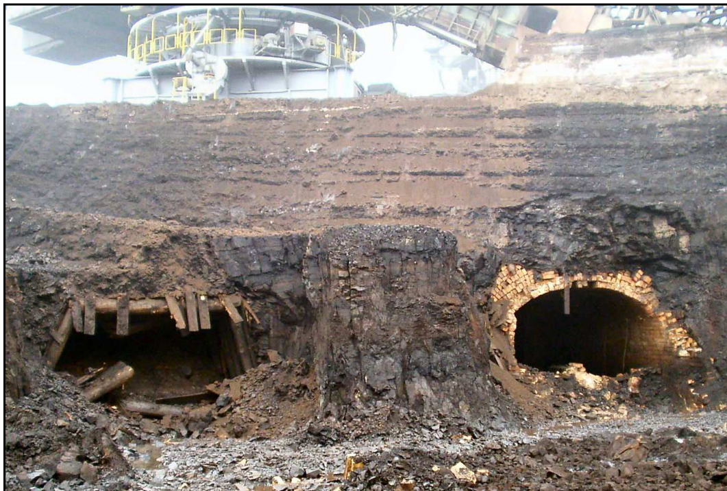
Abb. 3.5.-12: Tagebauanschnitt von zwei Förderstrecken in Holzausbau und Mauerwerk (Quelle: ROMONTA GmbH)
