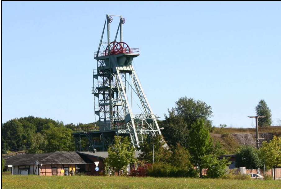
Abb. 3.3.3.3.-2: Ansicht des Röhrig-Schachtes
