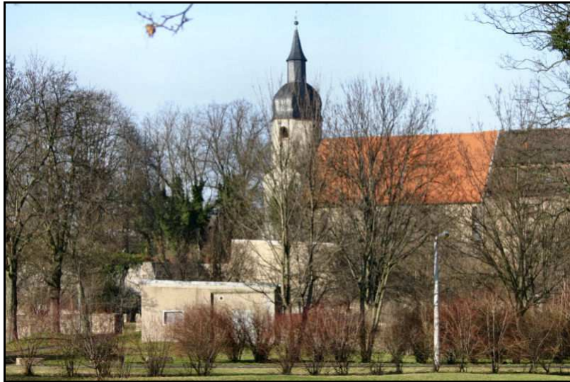
Abb. 3.3.2.3.-9: Umbautes Mundloch des Wiederstedter Stollens
