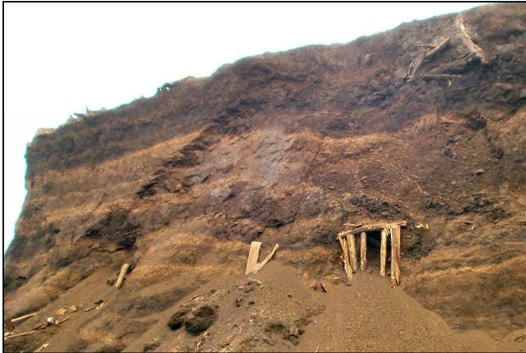
Abb. 3.5.-2: Tagebauanschnitt eines ehemaligen Braunkohlentiefbaus, der fast vollständig verschlossen ist (Quelle: ROMONTA GmbH Amsdorf)
