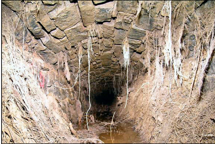
Abb. 6.2.-1: Wurzeln im Erdeborner Stollen (Quelle: BST Mansfeld GmbH & Co. KG Niederröbblingen)
