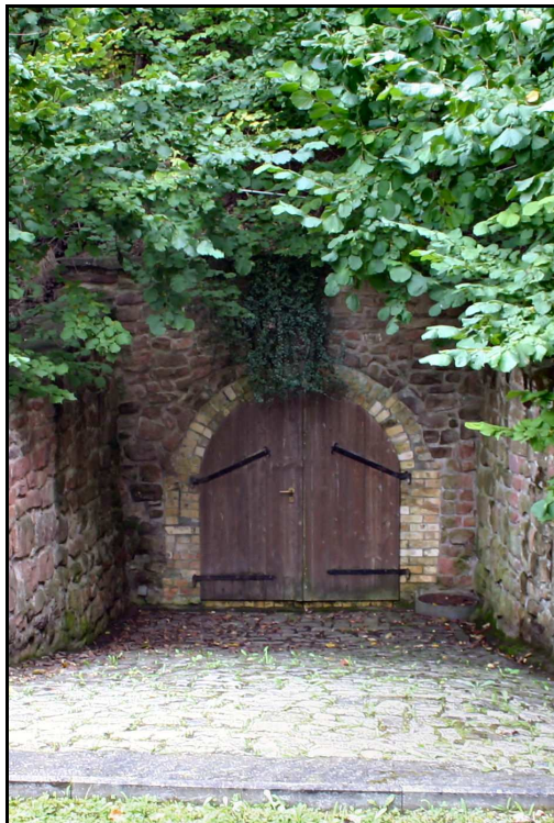
Abb. 3.3.3.2.-5: Das sanierte Mundloch des Mönch-Stollens
