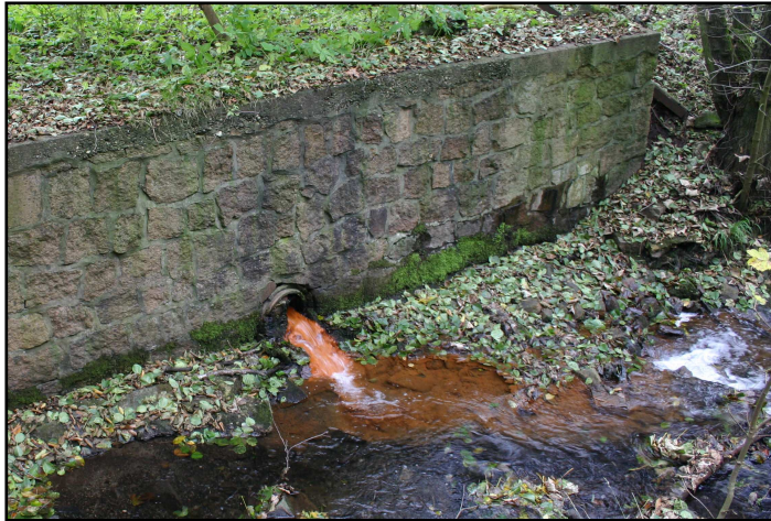
Abb. 5.2.-5: Abstoß Stollenwässer in die Vorflut
