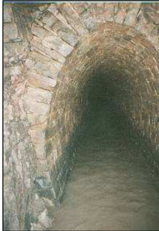
Abb. 3.3.3.2.-4: Stollen in Trockenmauerung
