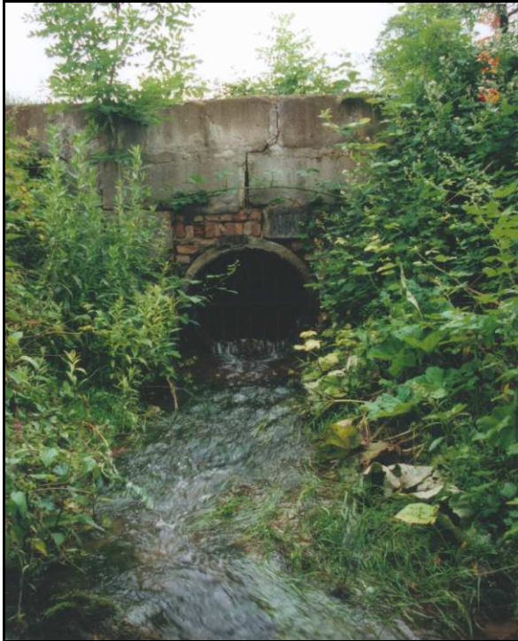
Abb. 3.3.3.2.-2: Das Mundloch des Gonnaer-Stollens
