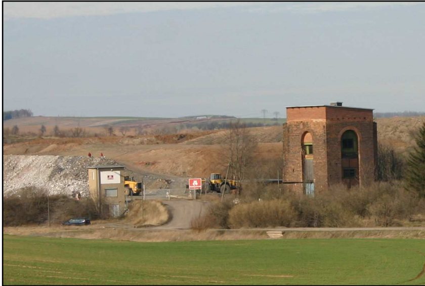
Abb. 3.3.2.2.-2 Historisches Schachtgebäude Freiesleben mit Haldengewinnungsbetrieb
