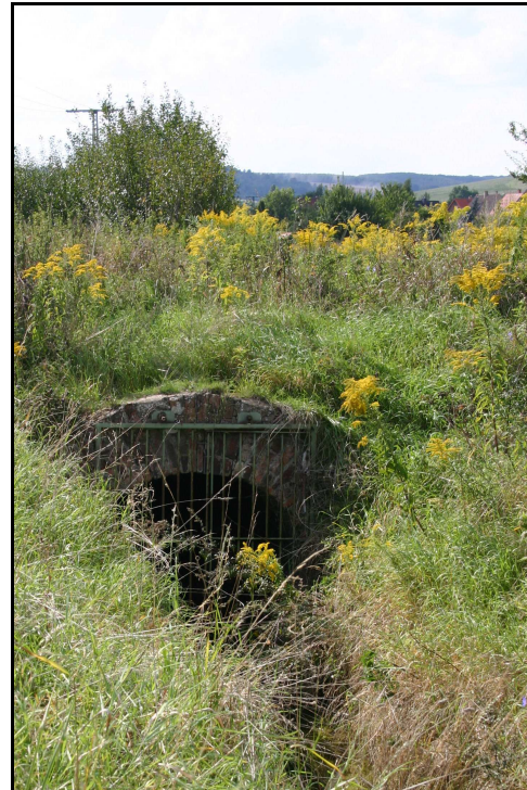
Abb. 3.3.2.3.-7: Mundloch des Erdebörner Stollens
