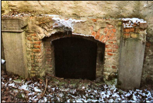
Abb. 3.3.2.3.-11: Umbautes Mundloch des Alteröder Stollens
